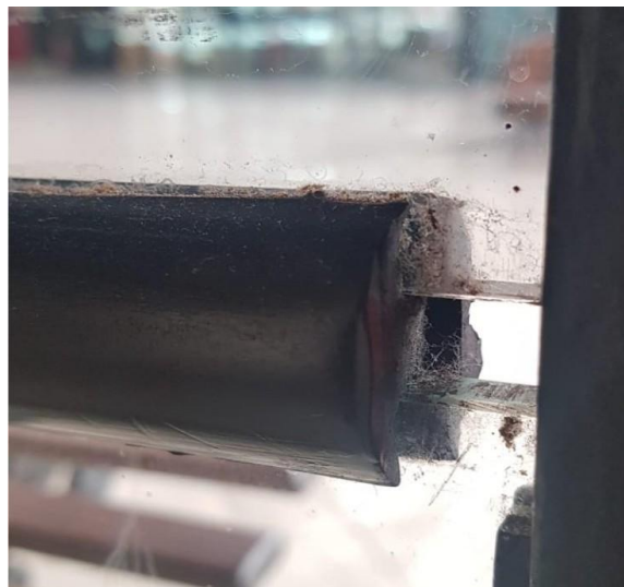
Foto 4: Perfis de borracha em H para inserção das folhas de vidro.
