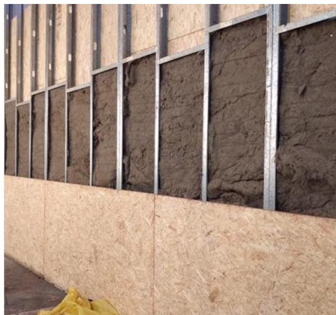
Imagem 7: Foto ilustrativa da construção das paredes em OSB, com instalação elétrica e isolamento acústicos embutidos. (Fonte: https://www.metallight.com.br/empresa-isolamento-termico )
