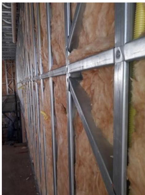
Imagem 7: Foto ilustrativa da construção das paredes em OSB, com instalação elétrica e isolamento acústicos embutidos. (Fonte: https://www.metallight.com.br/empresa-isolamento-termico )
