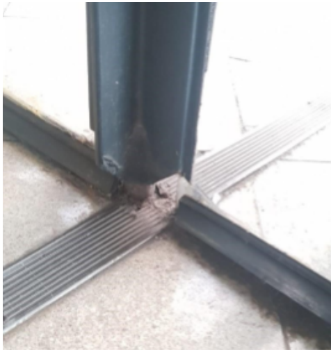
Foto 3: borracha de vedação inferior para soleira.
