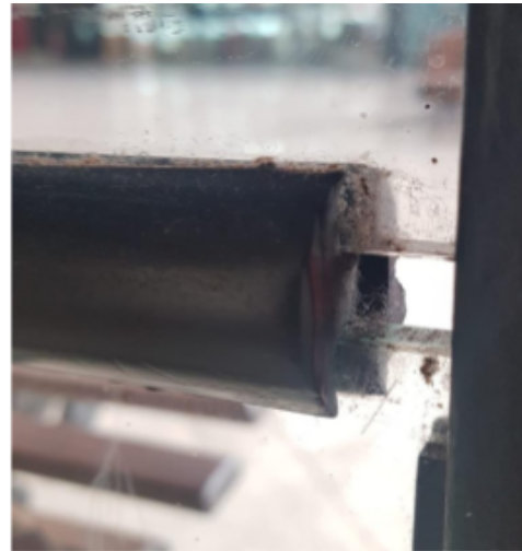
Foto 4: perfis de borracha em H para inserção das folhas de vidro.
