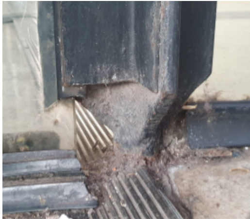
Foto 1: Fixação inferior feita por chumbamento do montante no piso
