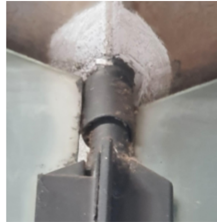
Foto 2: Fixação superior feita por solda à mesa inferior da viga metálica.
